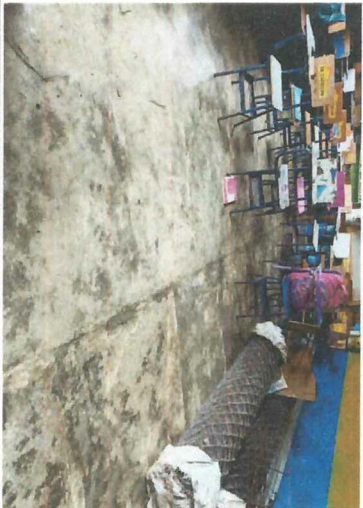
Foto 1: Fotografía del piso actual, el cual será intervenido y posteriormente será cerámico.
